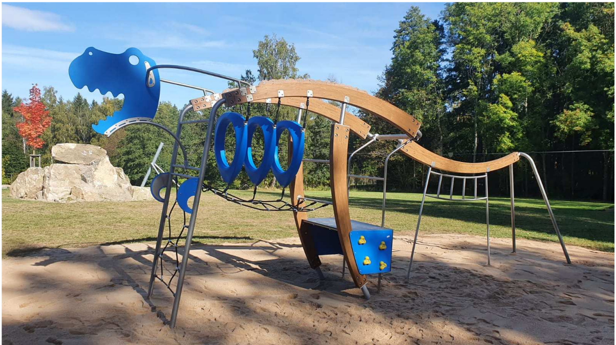
Abbildung 9: Errichtung eines Klettergerüsts Dinosaurier; Foto: Georg Straub
