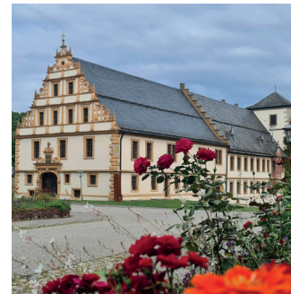
M Abteigebäude Maria Bildhausen
