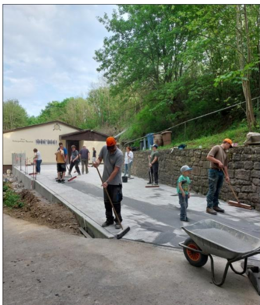
Abbildung 15: Der erneuerte Vorplatz im Bau und fertiggestellt
