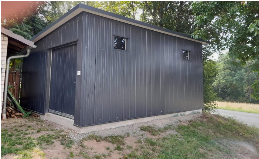
Abbildung 18: Neue Lagerhalle am Sportgelände des SV Pfeil Niederlauer
